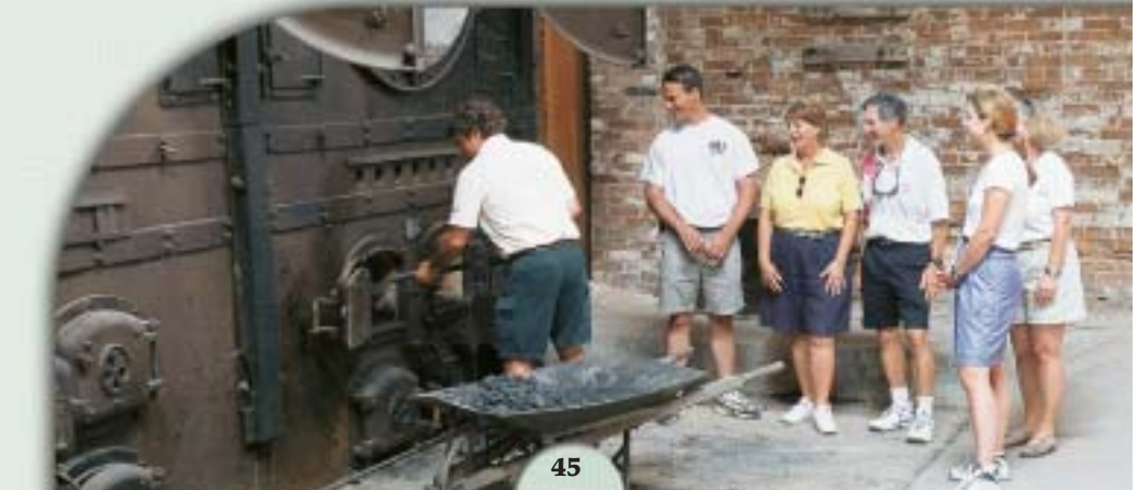
Les chaudières de l'édifice de désinfection Parcs Canada / E. Kedl
