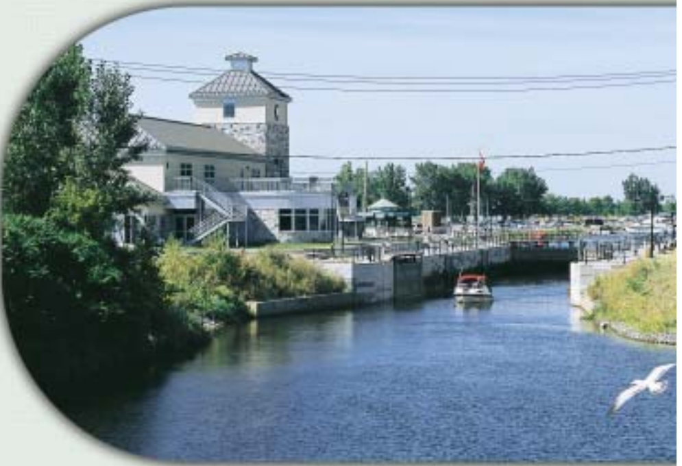
Le centre de services aux visiteurs et l'écluse de Lachine
