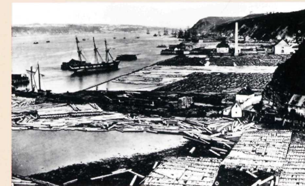
Anse à bois de Québec Québec Timber Cove
