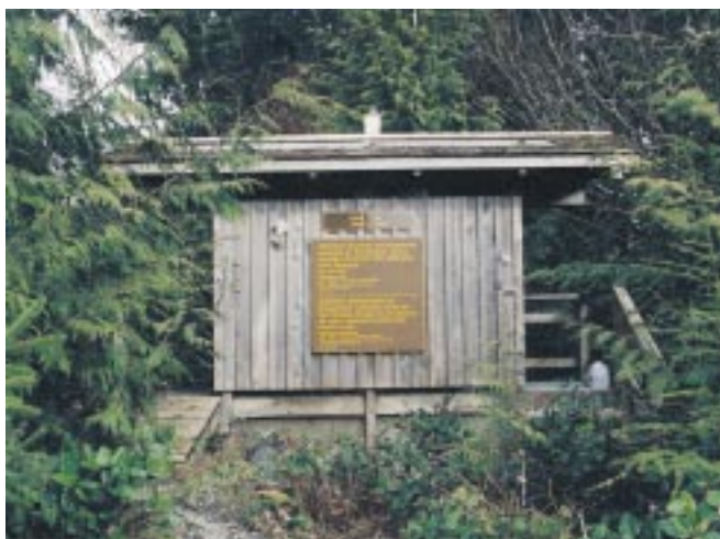
Cette toilette extérieure de la Réserve de parc national Pacific Rim est munie d'un système de compostage qui élimine virtuellement tous les déchets. De plus, le ventilateur est actionné par l'énergie solaire. P. Wilkinson
