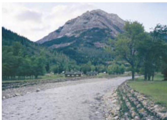
Ce cours d'eau a été reconfiguré parce qu'il inondait périodiquement un terrain de camping du parc national des Lacs-Waterton.
