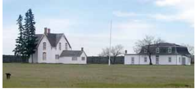
Résidence du commandant et quartiers des officiers (Parcs Canada)
