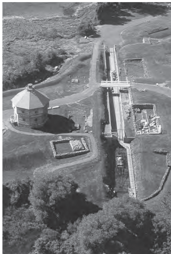
Vue aérienne du canal et du blockhaus Parcs Canada / Jean Audet
