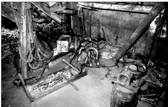
Artefacts exposés à l'intérieur de la drague pendant les travaux de stabilisation, 1991
