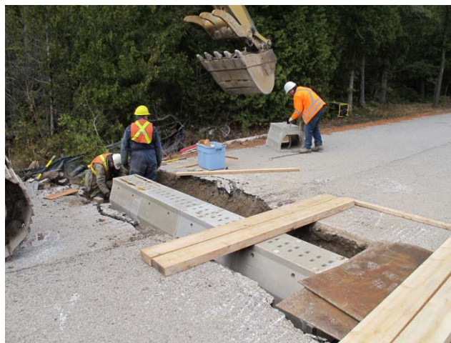
Une équipe d'ouvriers installe l'écopassage sur le chemin du lac Cyprus.
