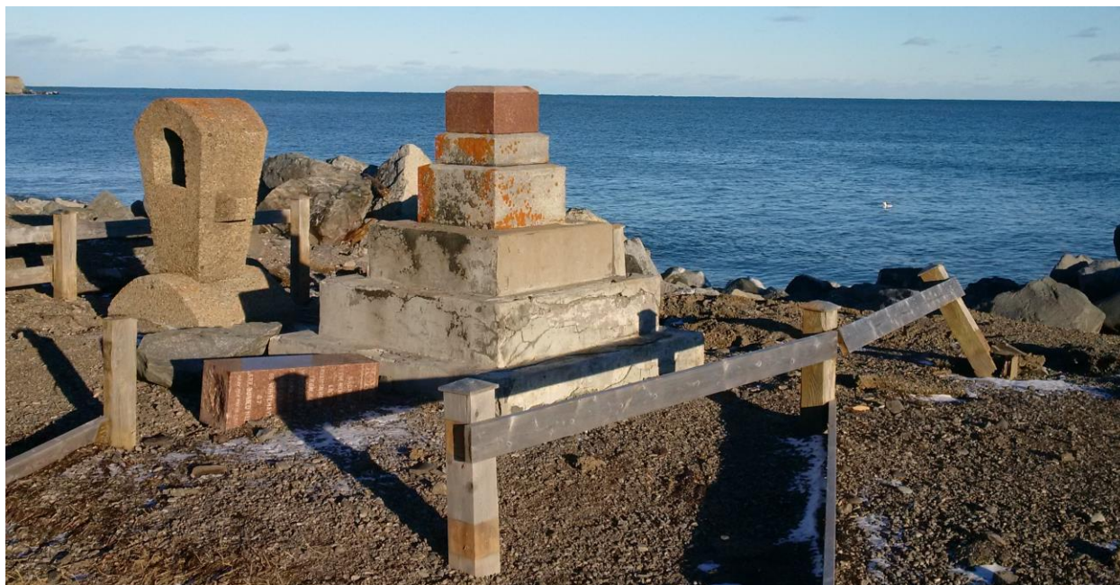
Figure 8. Exemple des impacts observés avant la réalisation des travaux sur le Monument aux Irlandais – Source : Parcs Canada, 2016
