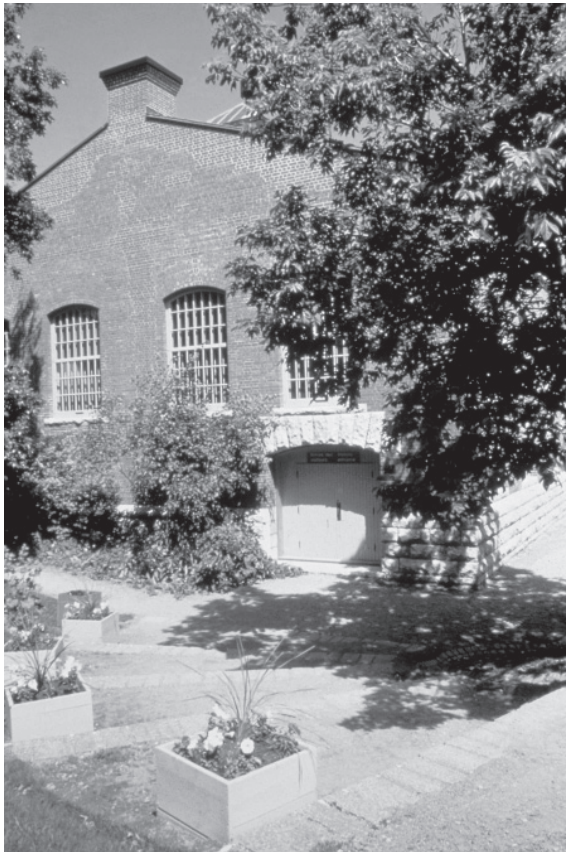
Le centre d'interprétation du Parc-de-l'Artillerie, installé dans l'ancienne fonderie de l'Arsenal Parcs Canada / X. Bonacorsi
