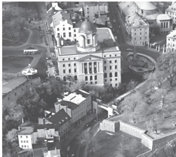
La passerelle construite à l'emplacement de la porte Prescott en 1983 a permis de compléter la promenade de lord Dufferin dans ce secteur. Parcs Canada, Service de la planification
