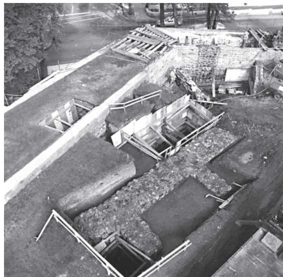
Le tracé du mur de fortification de Levasseur de Neré diffère de celui du mur actuel, conçu par Chaussegros de Léry. Parcs Canada / M. Élie
