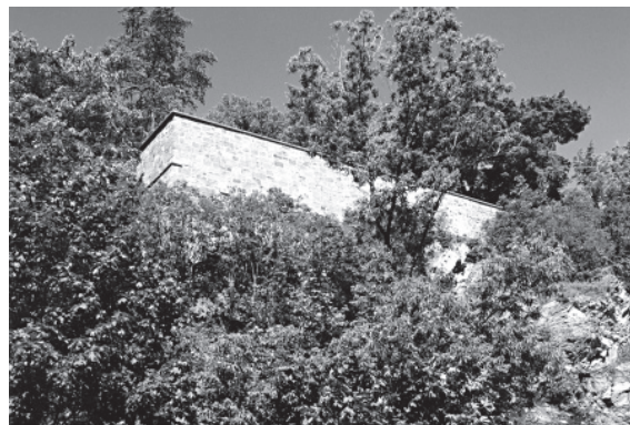
Les arbres matures, en plus de bloquer des vues significatives, nuisent à la stabilité de l'escarpement. Parcs Canada
