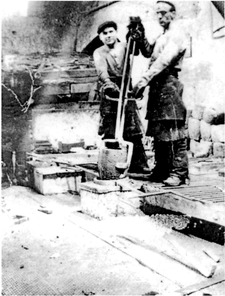
Des ouvriers travaillant au four à creusets de la fonderie de laiton en 1909. Ils utilisent une happe, une sorte de pince à long manche, et un brancard, un outil dans lequel on insère le creuset pour aller remplir les moules.
