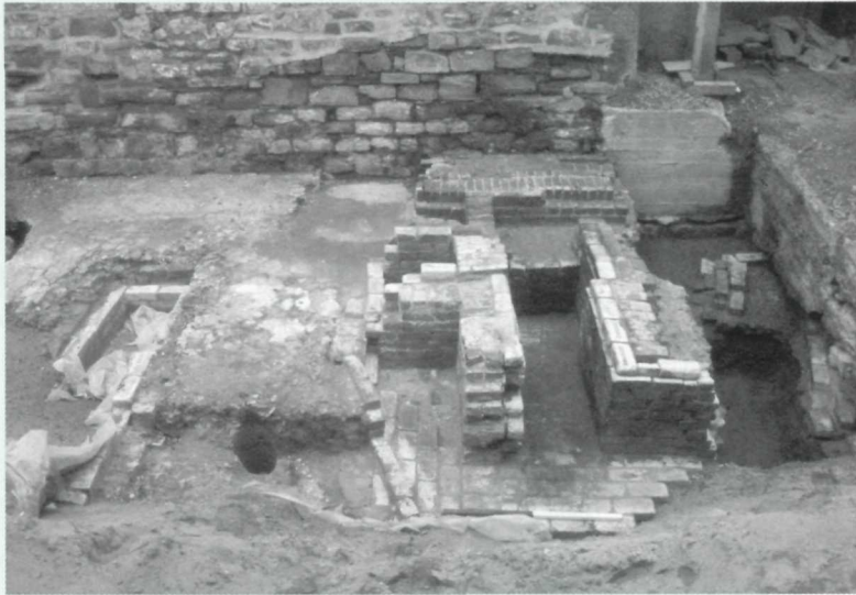
Portion ouest du four à creusets construit en 1902-1905.
