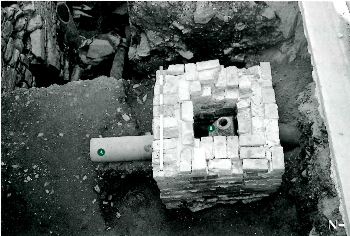
Le drain de plancher de la salle d'ablution avec son tuyau d'évacuation des eaux usées (A). À l'intérieur, se trouve l'appareil de désodorisation au charbon de bois (B).
