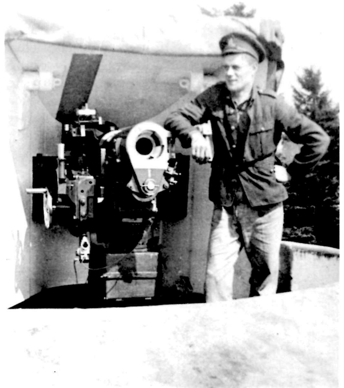
Un des deux canons de 12 livres à tir rapide a été installé à la batterie Belmont en 1900. La photo date de 1924.
