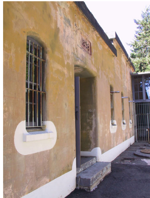
Centrale des projecteurs A. Gavin, CSOC 2003
