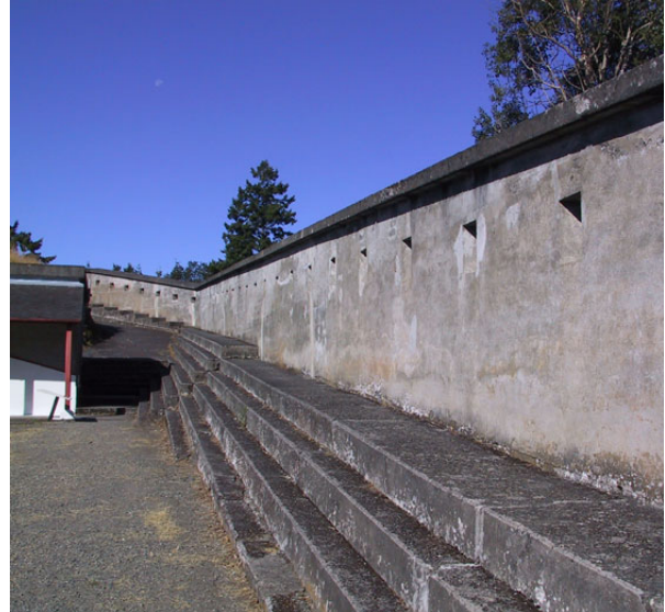
Casernement de la casemate A. Gavin, CSOC 2003
