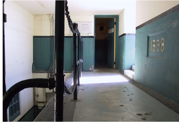
Intérieur de la batterie Belmont A. Gavin, CSOC 2003
