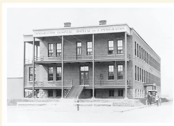
Hôpital du Parc Savard, à l'origine de l'hôpital du Christ-Roi à Québec
