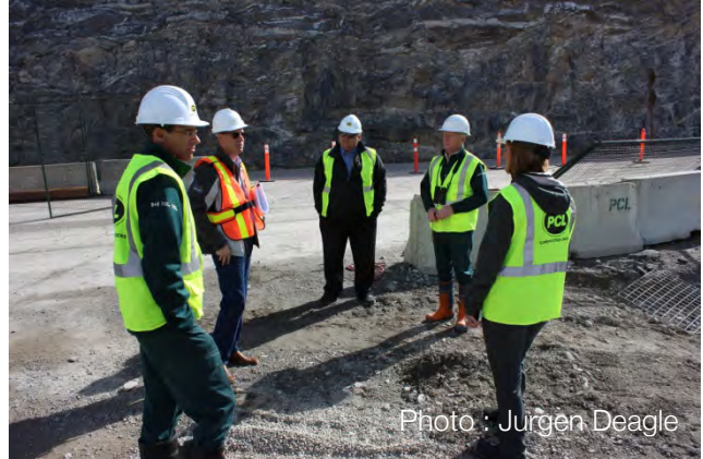
Surveillance du chantier de construction de la passerelle Skywalk
