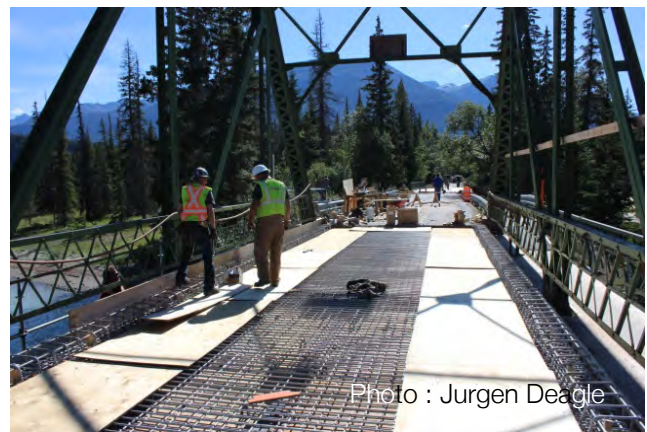
Remplacement du tablier des ponts de la colline Old Fort Point
