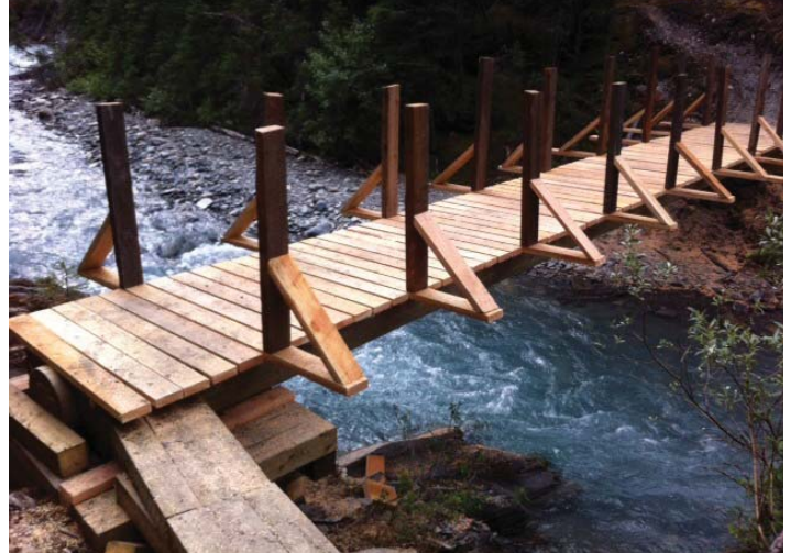
Nouveau pont en construction sur le ruisseau Numa. (© Parcs Canada / J. Hearnden)
