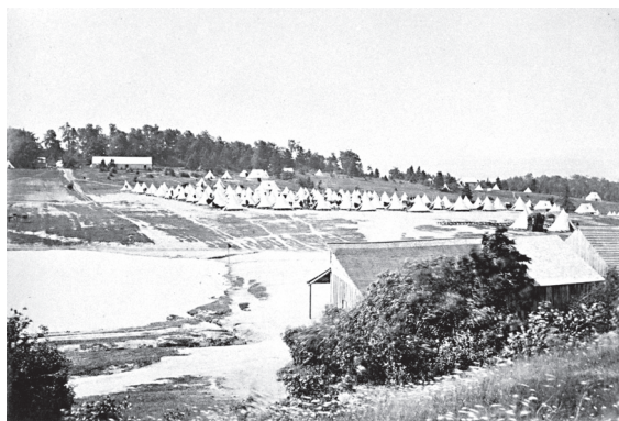
Le camp du 53 e régiment, présent sur le chantier du fort Numéro-Un en 1867 et en 1869
