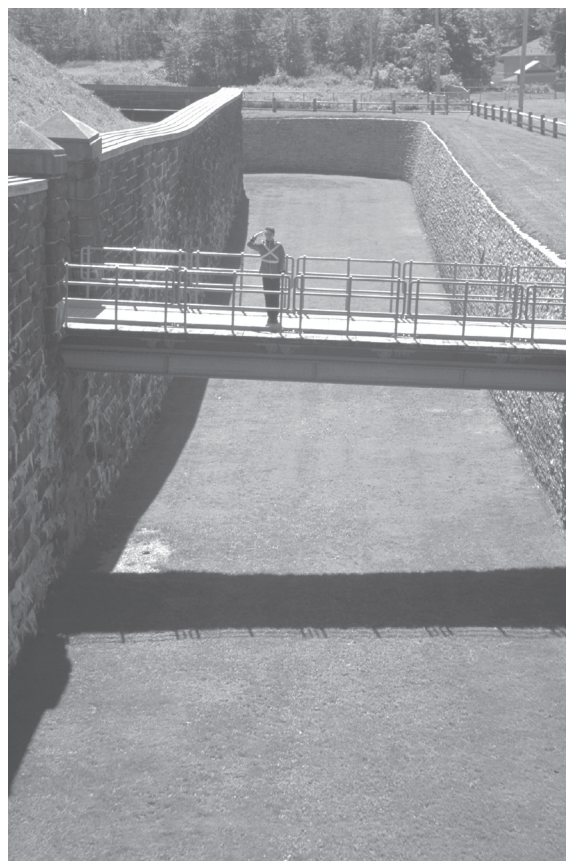
Vue du fossé et du pont roulant à la hauteur de la demi-gorge droite Parcs Canada
