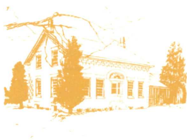
La ferme Spillway
