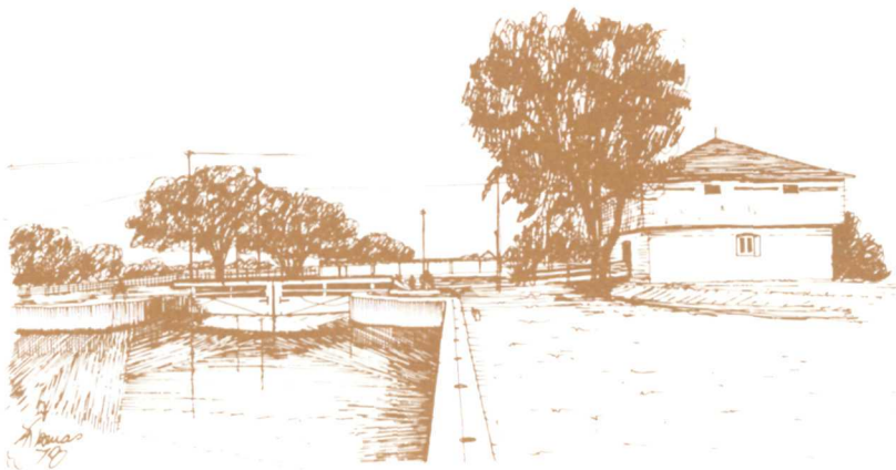
Le blockhaus et l'écluse d'amont
