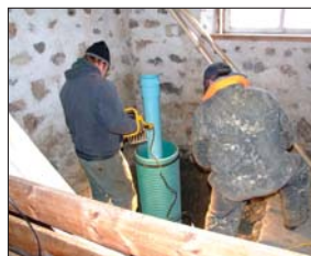
INSTALLATION DE LA CONDUITE MAÎTRESSE, MAISON DE PIERRE / PARCS CANADA / S. HELFRICK / 2008
