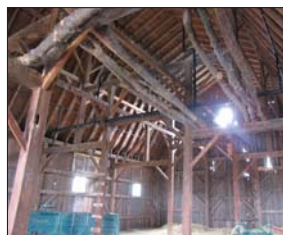
SYSTÈME D'EXTINCTION DES INCENDIES, FENIL DE L'ÉTABLE PARCS CANADA / C. ARCHER / 2009
