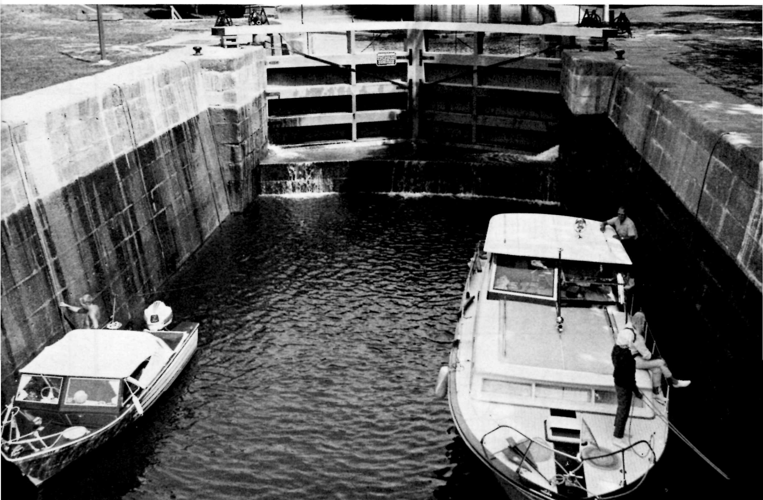
En attendant que l'eau atteigne son niveau normal, à l'écluse 37 du canal Rideau, située à Chaffeys.
