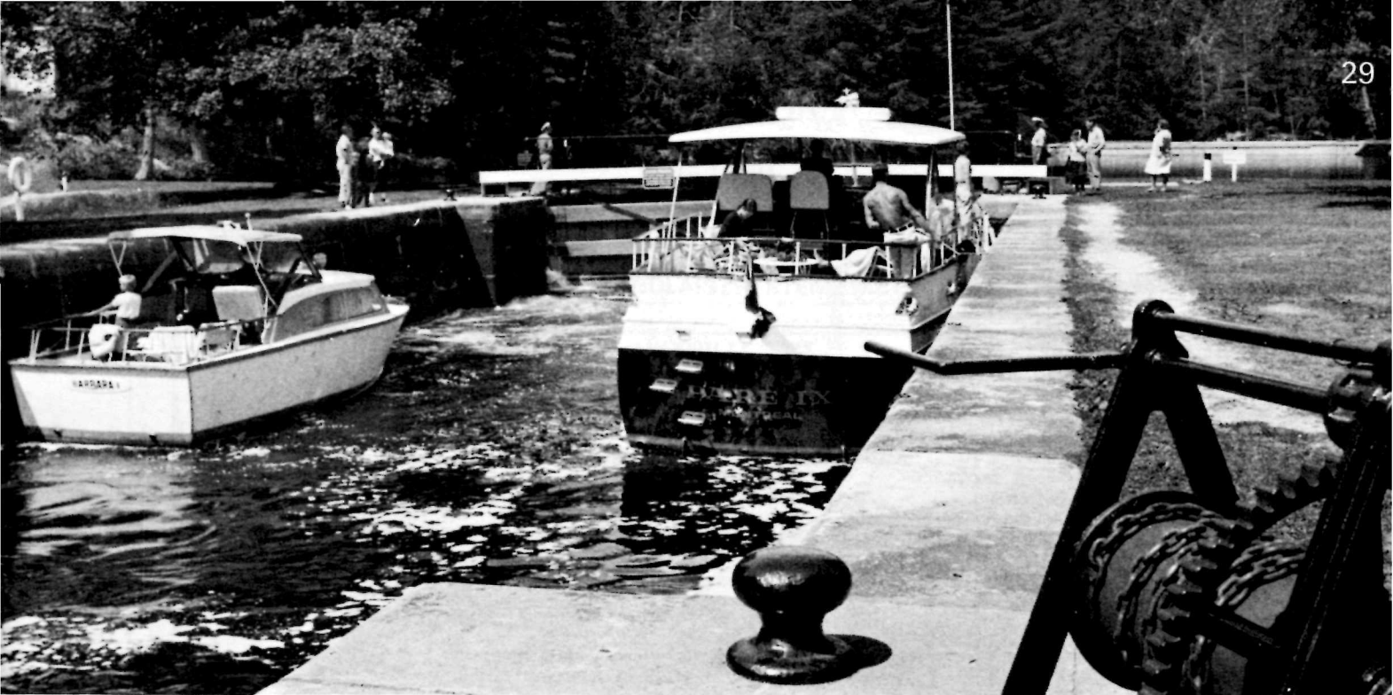
L'eau bouillonne autour de ces embarcations et atteindra bientôt son niveau normal, à l'écluse 40 de Jones Falls.
