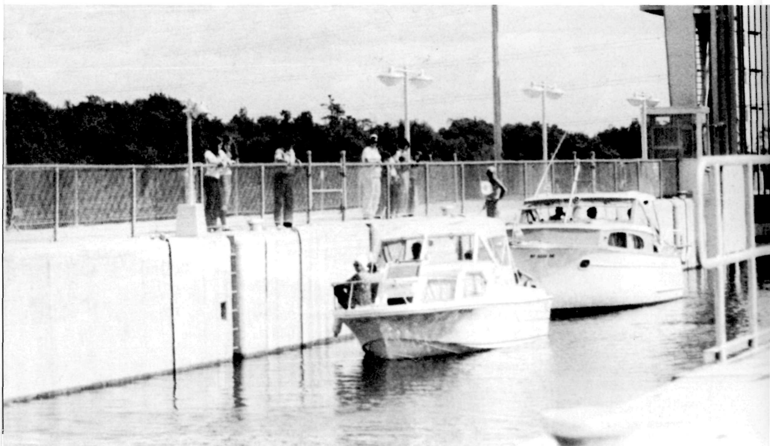
Dans l'écluse de Carillon, sur la rivière des Outaouais.
