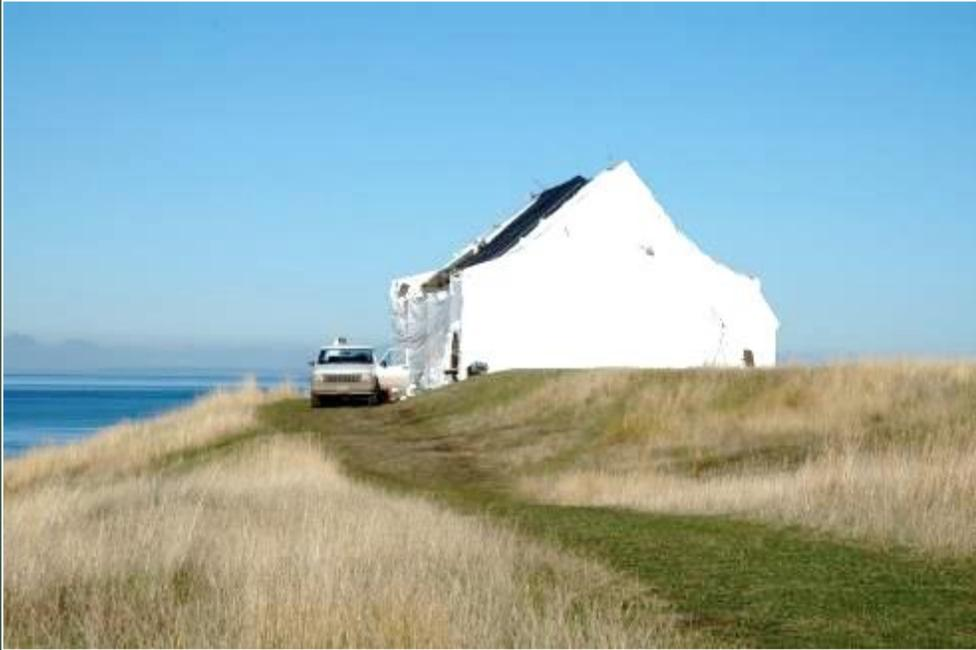
Encapsulation d'un bâtiment pendant des travaux d'atténuation des effets de la peinture au plomb, île Saturna, réserve de parc national des Îles-Gulf
