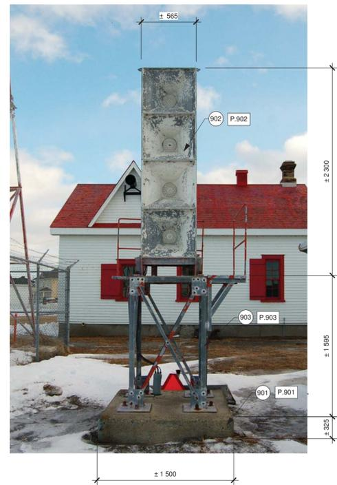
ELECTRONIC FOGHORN - NORTH ELEVATION / CRIARD ÉLECTRONIQUE - ÉLÉVATION NORD
