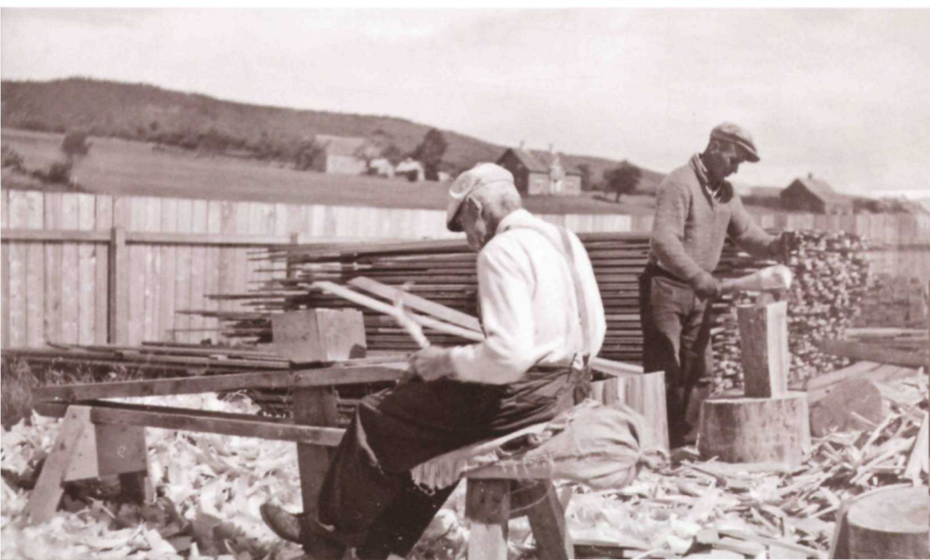
Artisans se servant d'outils traditionnels pour fabriquer des bardeaux de fente
