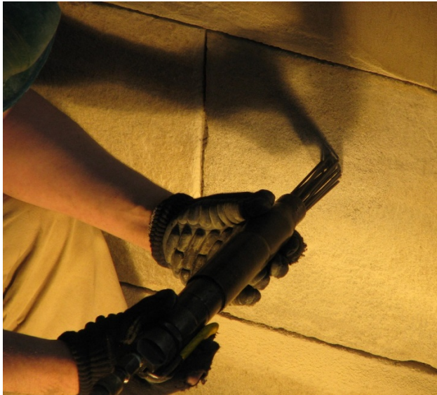
Vue du travail sur un bloc de grès, LHN Province House
