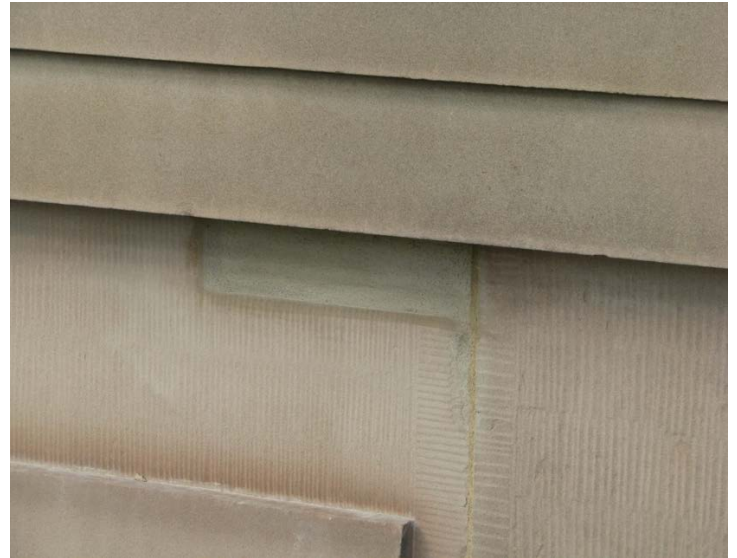
Vue de l'exécution soignée des joints et des réparations du grès, LHN Province House
