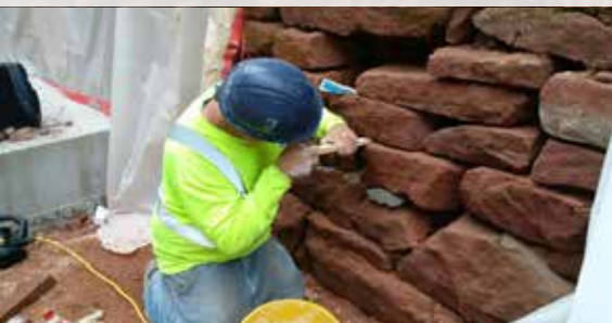
Fondation en pierres de l'île après un dégarnissage en profondeur des joints (à gauche) et remplissage des vides en cours (à droite). Photos gracieusement fournies par le secrétariat de la conservation du patrimoine, 2017.
