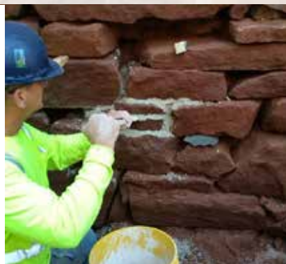
Essai de réparation in situ terminé
