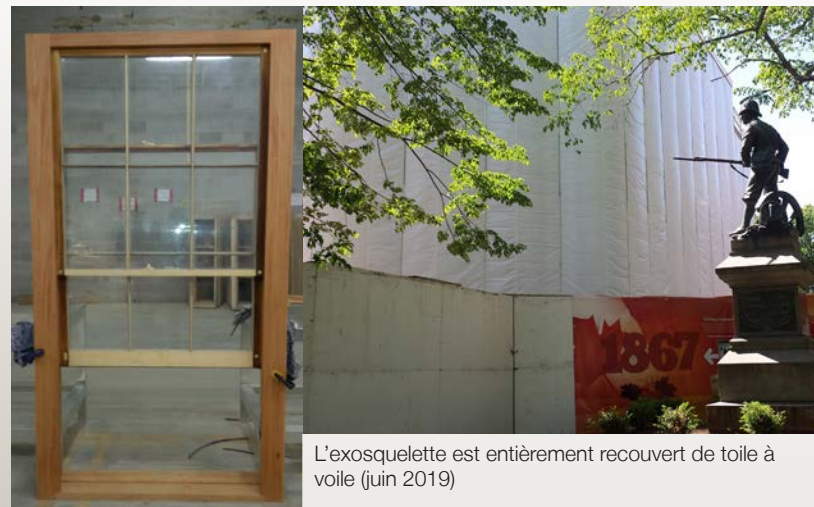
Cadre et appui de fenêtre réparés (avril 2019)
