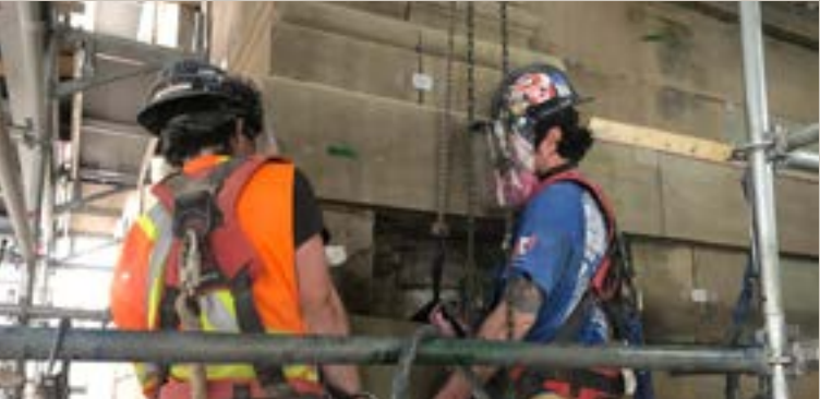
Deux maçons portent tout l'équipement de protection individuelle (EPI) ainsi que des visières pendant l'installation d'une pierre.
