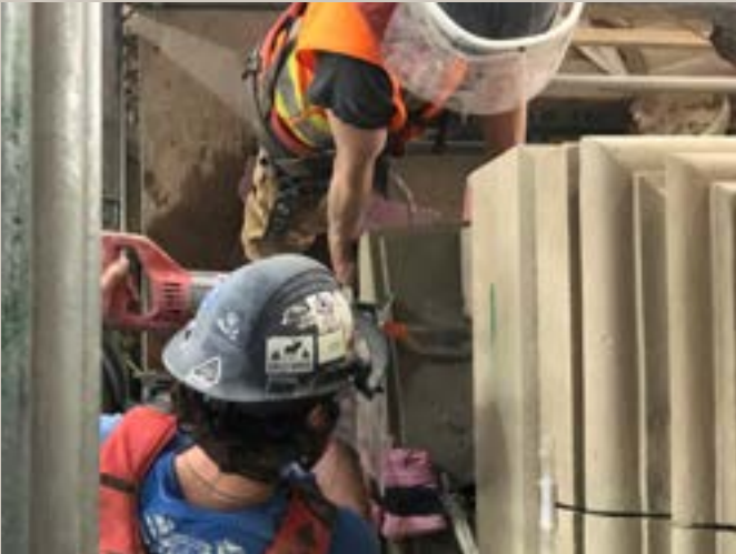
Deux maçons travaillent dans un endroit exigu tandis qu'ils installent une pierre extérieure.
