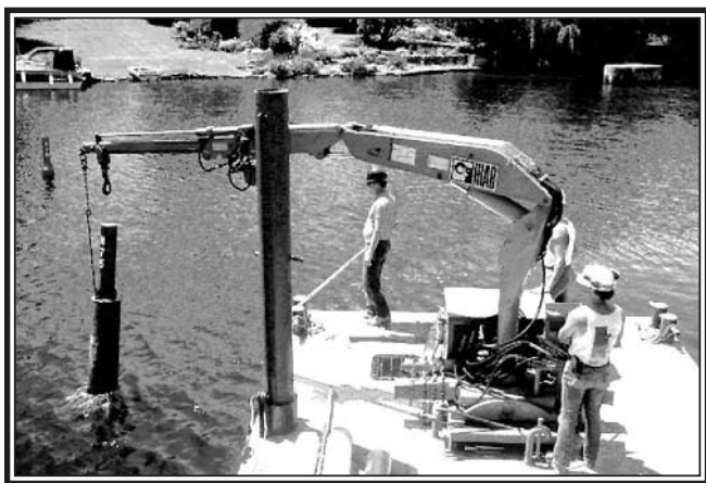
Mise en place d'aides à la navigation dans le canal près de Manotick Collection de photographies du canal Rideau
