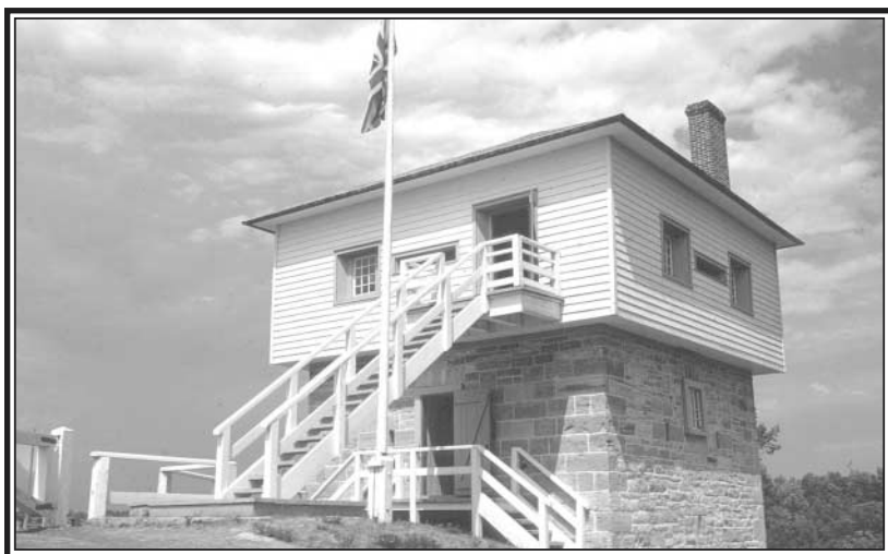
Blockhaus de Kingston Mills, Collection de photographies du canal Rideau
