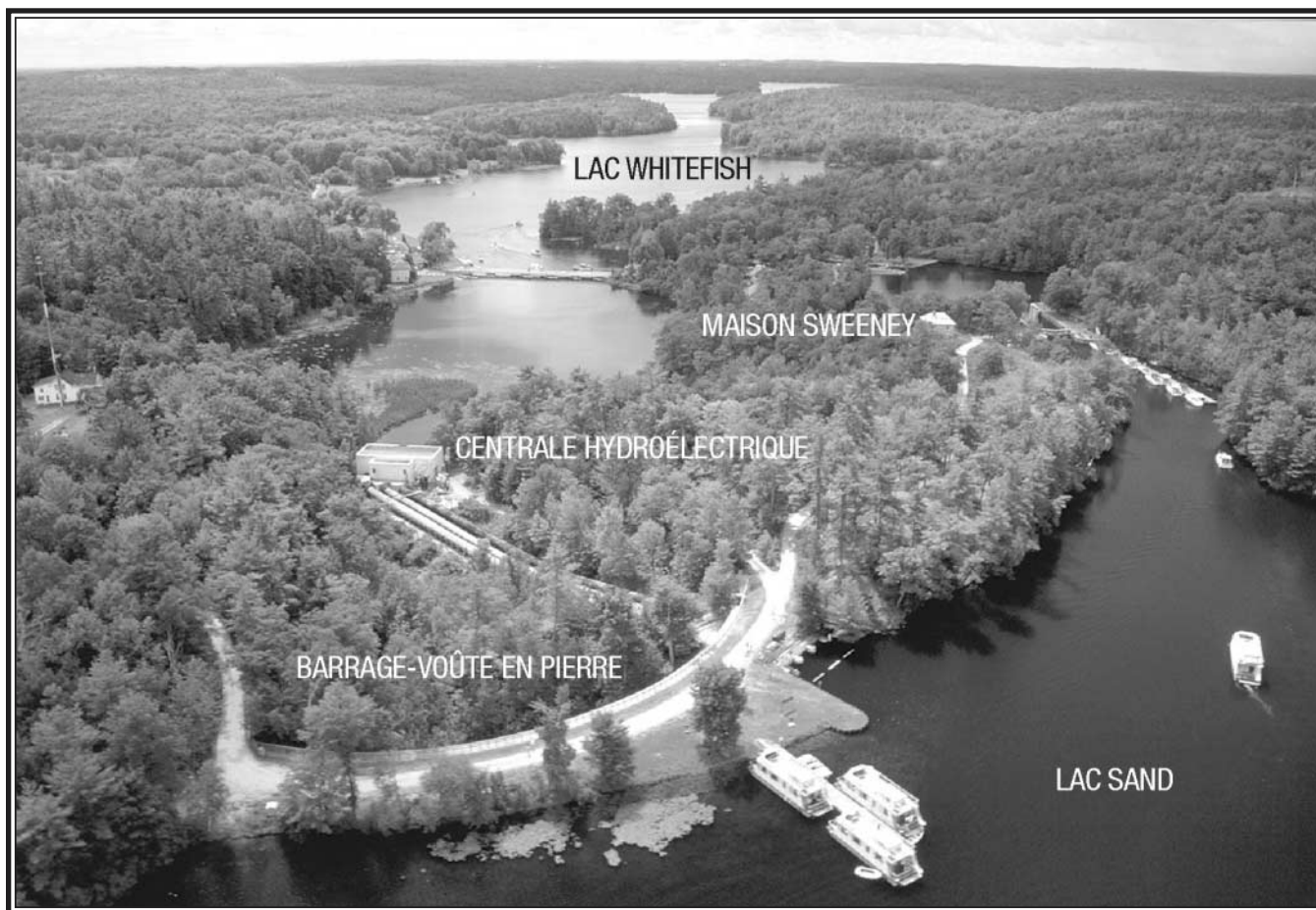
POSTE D'ÉCLUSAGE DE JONES FALLS
