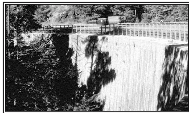
Barrage-voûte en pierre à Jones Falls
