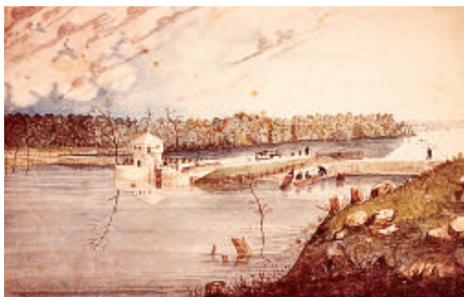
08 L'écluse, le barrage régulateur et le barrage en matériaux meubles de 400 mètres de long à The Narrows créent un tronçon permettant de naviguer jusqu'au poste d'éclusage de Newboro.
