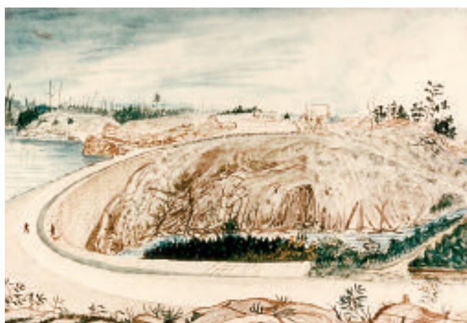
10 Le barrage-voûte en pierre de Jones Falls est une remarquable prouesse d'ingénierie.
