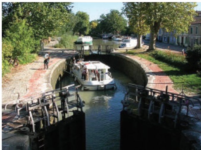
Le Canal du Midi dans le Languedoc en France possède des écluses aux parois courbes pour résister à la pression de la terre et pour accueillir plus de bateaux.
