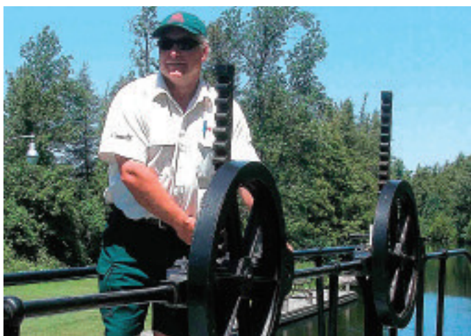
Les portes et les vannes sont encore actionnées au moyen de treuils manuels.
