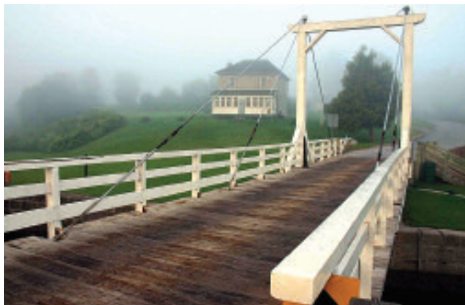
Des plans originaux ont été utilisés pour construire les ponts tournants de type Kingpost que l'on voit de nos jours à certains postes d'éclusage.
