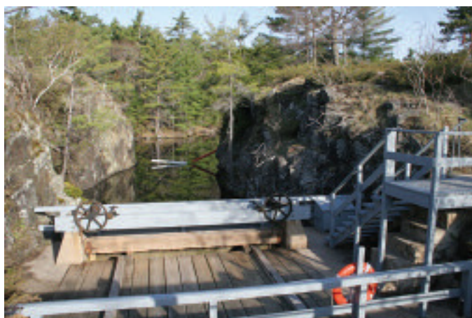
Le barrage régulateur de Jones Falls fait partie du système complexe de barrages de ce poste d'éclusage.
