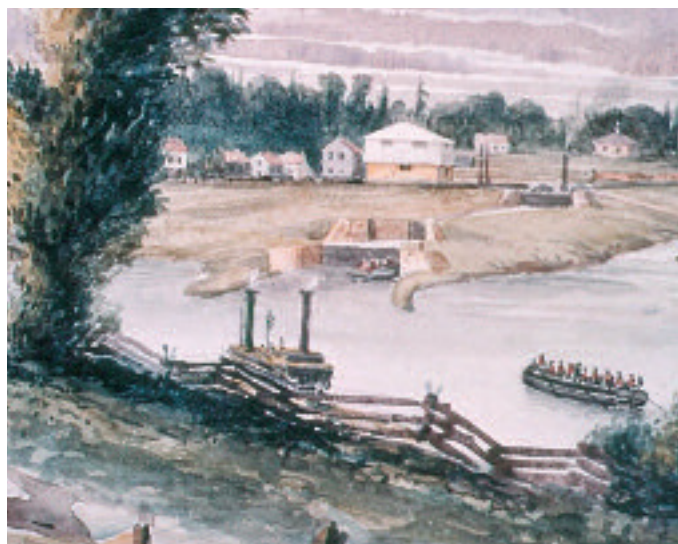
13 Le blockhaus construit pour protéger les écluses à Merrickville.
