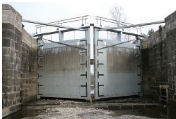
À l'origine, les portes d'écluses étaient faites de chêne, mais en raison de la rareté des chênes ayant les dimensions voulues, on utilise maintenant du douglas taxifolié.
