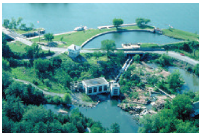
Le réseau de plans d'eau supposait dans de nombreux cas la construction d'une série de barrages, comme ici à Kingston Mills.
