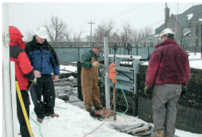
On recourt aujourd'hui à des techniques d'injection qui endommagent moins les matériaux d'origine.
