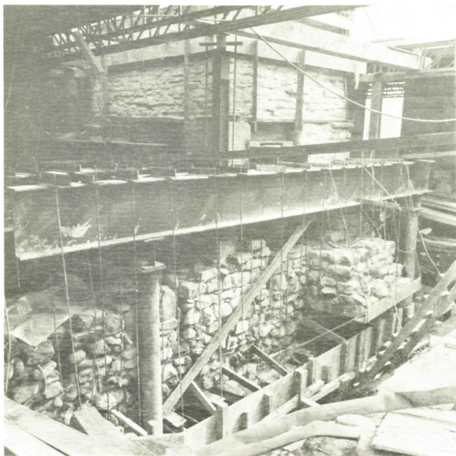
STABILISATION DE LA CHEMINÉE D'AFFINERIE (FORGE BASSE).
