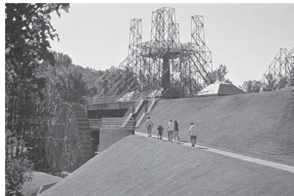
Volume expressif abritant les vestiges du haut fourneau Parcs Canada / E. Kedl
