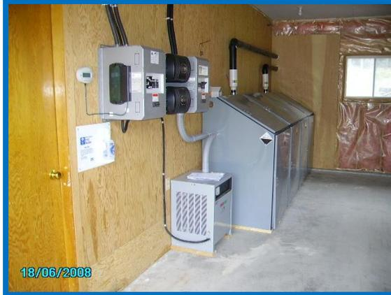
**Photographie 3 :** Onduleurs, contrôleurs de charge et batteries
