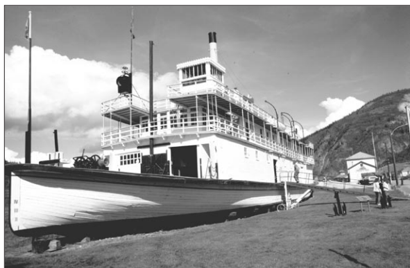
Le S.S. Keno, vu de la proue, ouvert pour des visites guidées avant la stabilisation de la coque
