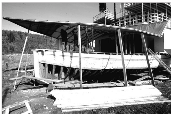
Le S.S. Keno pendant les travaux de stabilisation de la coque
