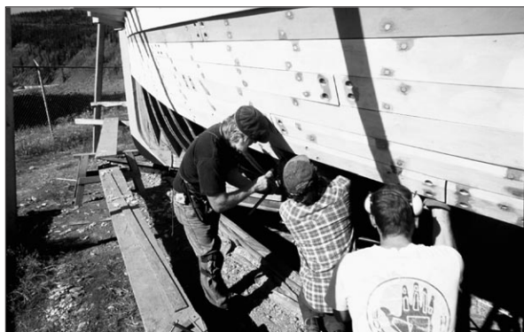
Équipe travaillant à la réparation de la coque du S.S. Keno
