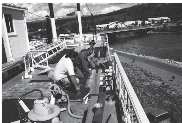
Enlèvement de la pourriture sur le pont avant la réparation de la toile
