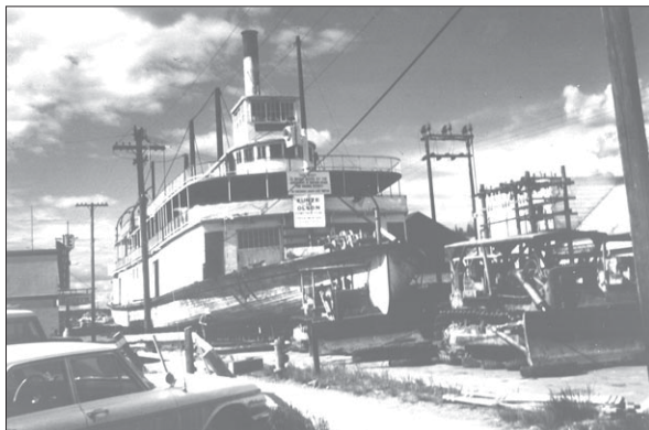
Des bulldozers déplacent le S.S. Klondike du chantier naval de Whitehorse à son emplacement actuel, 1966 (Collection de G.I. Cameron)
