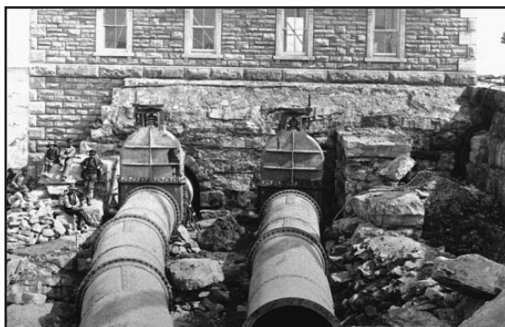
Conduites forcées amenant l'eau aux turbines de la centrale
