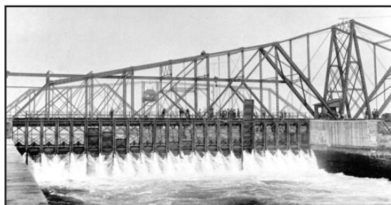
Le barrage tournant de secours en service lors de l'accident de 1909
