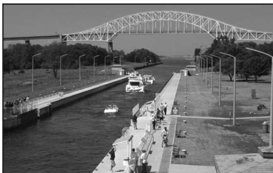
Embarcations de plaisance quittant l'écluse
