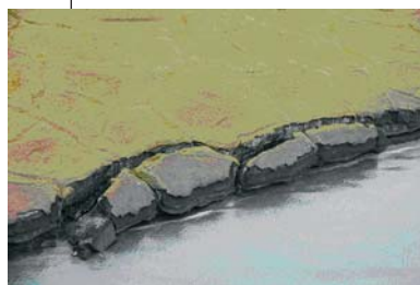
FIGURE 1. Les ruptures en blocs telles que celle-ci à l'ouest de la plage Komakuk sont courantes le long de la côte du Yukon. Elles se produisent généralement le long de coins de glace (indiqués par des cuvettes à la surface de la toundra) et on peut voir le coin exposé près du haut de la falaise côtière. Maintenant que le bloc est tombé sur la plage, il peut être érodé plus facilement par les vagues, et les sédiments et le carbone dans le sol seront transférés dans l'océan
