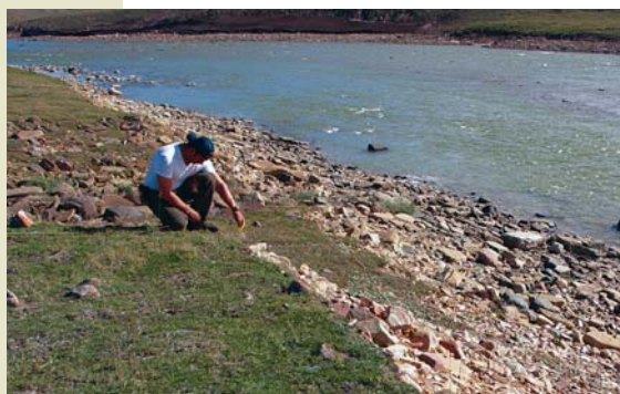
Surveillance de l'érosion d'une berge près d'un site culturel le long de la rivière Hornaday.
