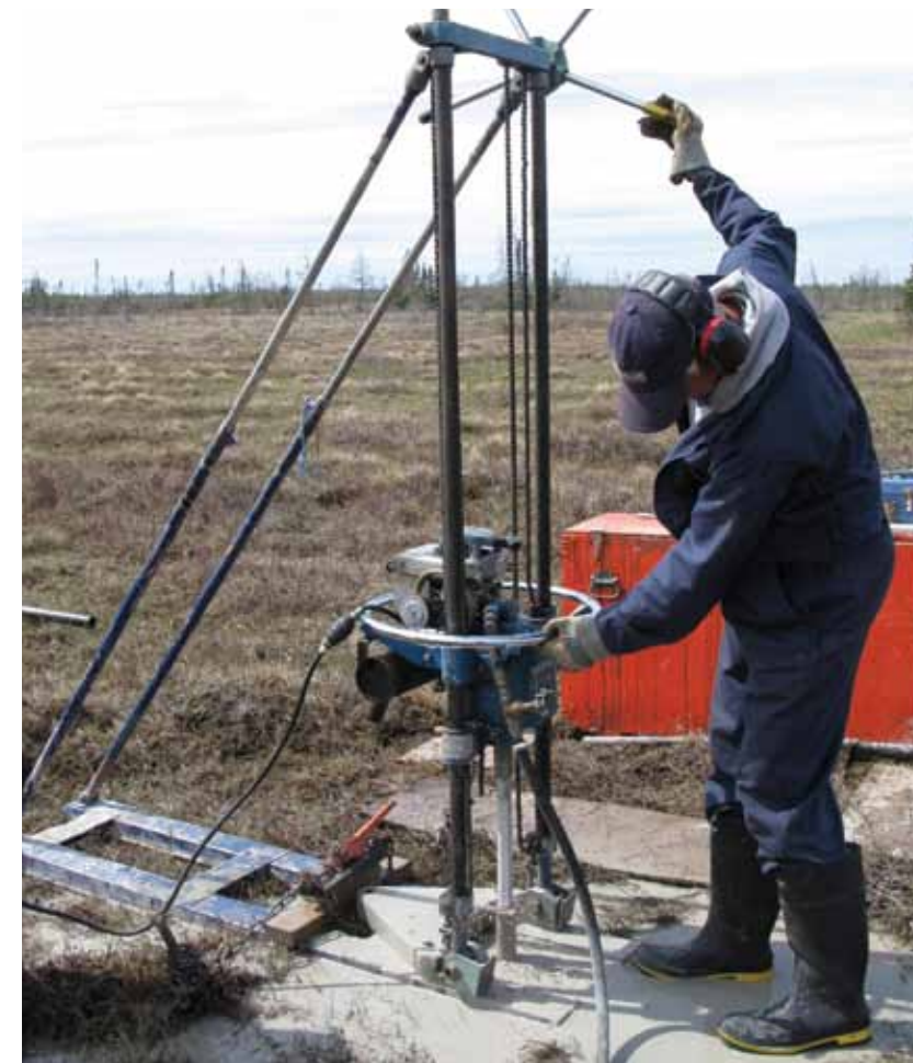
Foreuse à diamant à poids léger utilisée pour installer les câbles thermistance. Source : Wendy Sladen
