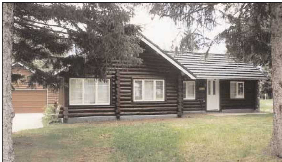
303, avenue Evergreen, construit en 1927-1928
