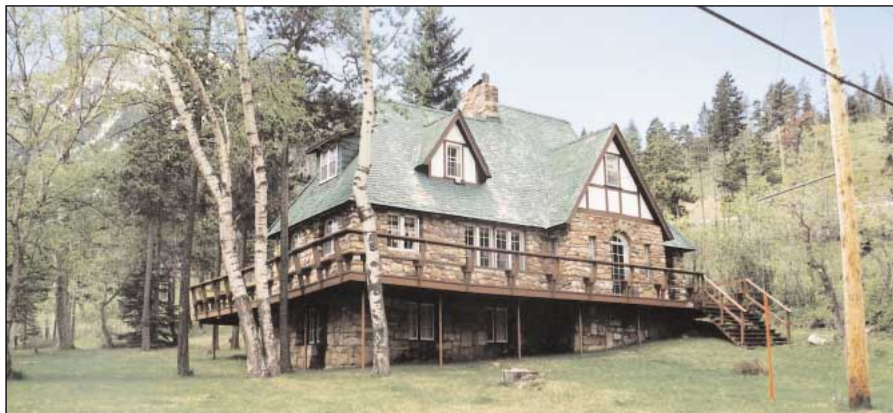
128, avenue Evergreen, construit en 1929-1934
