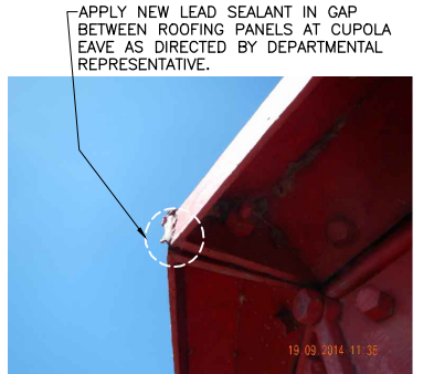
EXISTING CUPOLA EAVE DETAIL N.T.S.
