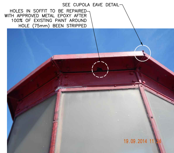
EXISTING CUPOLA SOFFIT DETAIL N.T.S.
