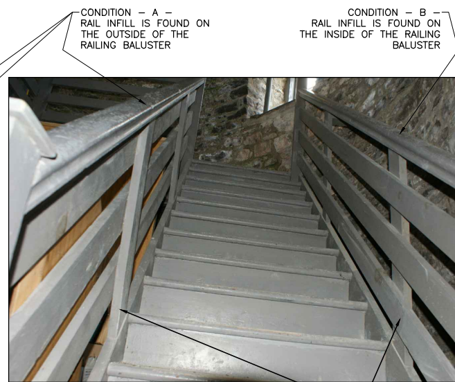
TYPICAL STAIR ELEVATION N.T.S.
