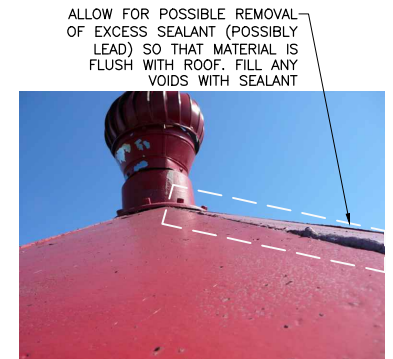
EXISTING CUPOLA ROOF N.T.S.
