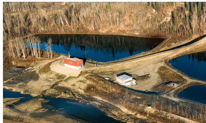
Ancienne usine de traitement des eaux usées de Grande Prairie et nouvelle station de pompage de l'eau brute en bordure de la rivière Wapiti (AENV)
