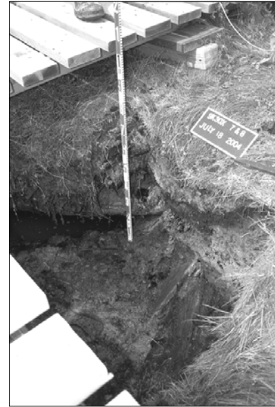
Doline dans la cour de l'entrepôt, vraisemblablement le résultat de problèmes de drainage. (L. Dueck)
