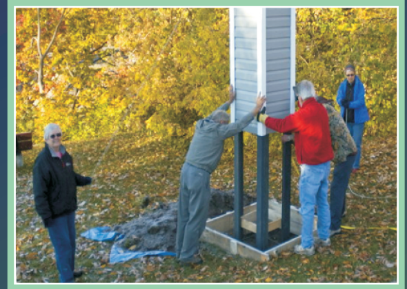
L'équipe régionale des lacs Kawartha a construit et installé des tours à l'intention des martinets ramoneurs, afin de compenser la perte d'habitat de nidification © Robbie Preston
